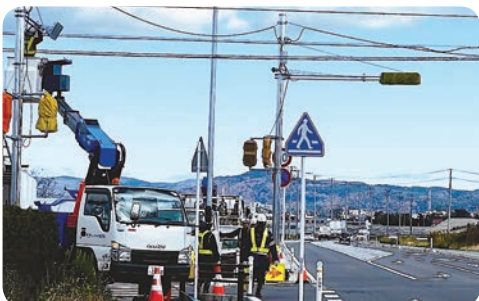
大曲地区に信号機を新設
